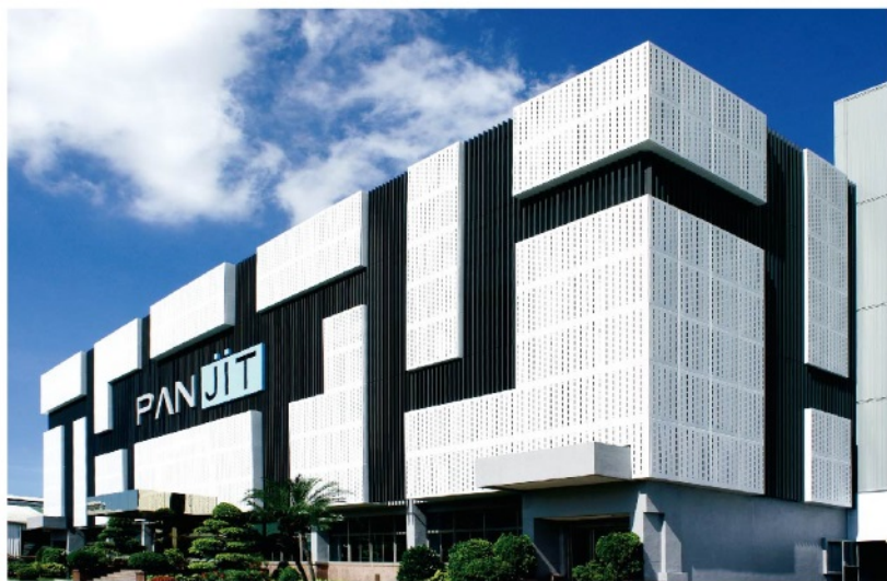
高雄岡山強茂電子廠外觀更新工程
