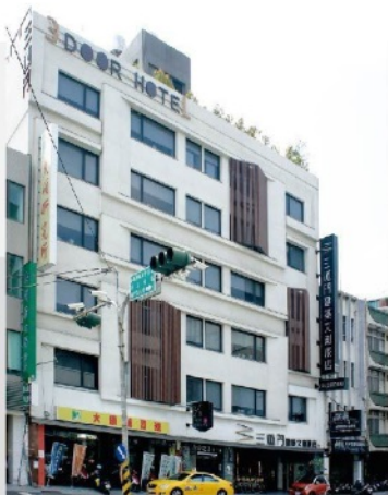
臺南市三道門建築文藝旅店整修工程
