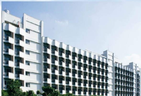
2019 高雄佛光山員工宿舍新建工程
