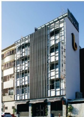
臺南市啤酒花大飯店整修工程
